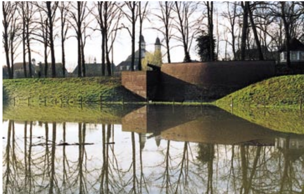
In 1997 zijn tijdens dijkverzwarrings-werkzaamheden te Ravenstein de restanten van twee vroege zestiende eeuwse bastions aan het licht gekomen. Deze zijn in 1999 hersteld en in het zicht gelaten | Foto: Jan Barnard
