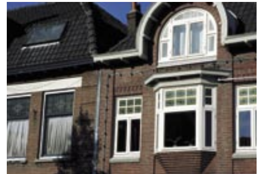
Gevel Hooghuisstraatr in Oss
