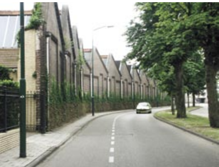
Zaagtanddaken van de voormalige Bergosstapijfabriek langs de oostwal in Oss
