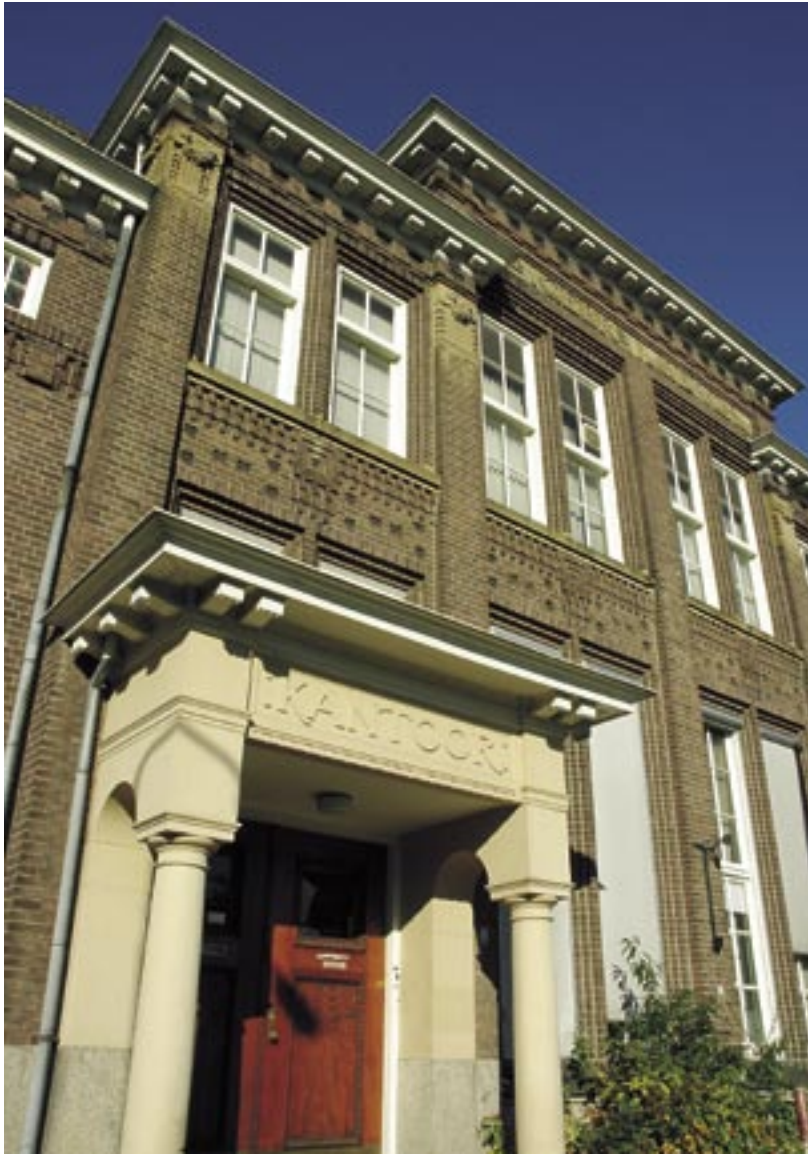
Kantoor Bergoss (1919) aan de Bram van de Berghstraat in Oss
